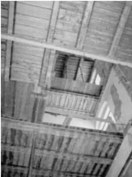
Künftiger Aufzugschacht – Blick vom Keller ins Dachgeschoss
